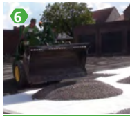
6 plaatsen van het grind
